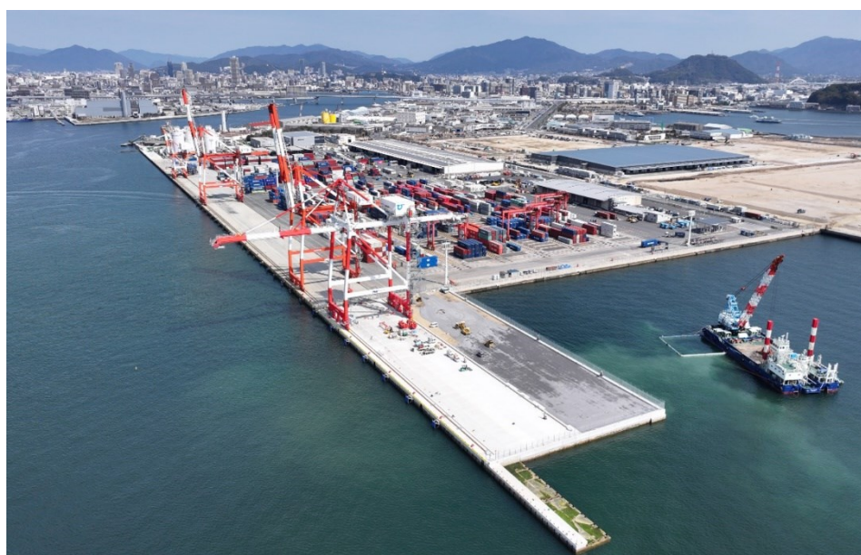
【広島港出島地区 岸壁整備】
