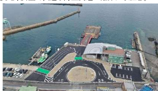
三高港ターミナル周辺整備
