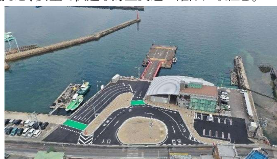
三高港ターミナル周辺整備
