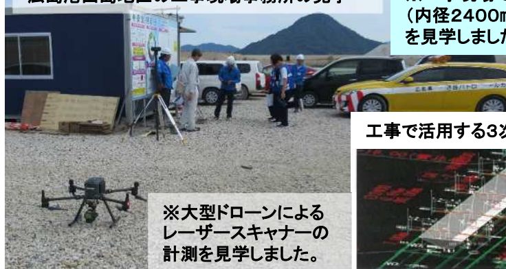
広島港出島地区の工事現場事務所の見学
