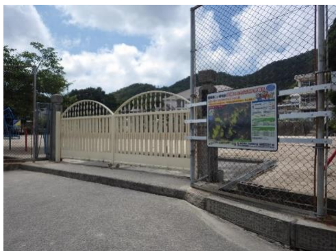
熊野第二小学校(安芸郡熊野町)
