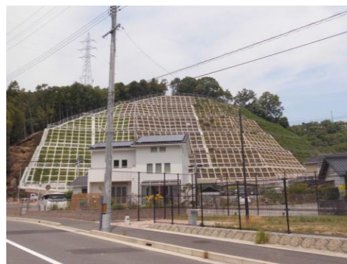
急傾斜地崩壊対策事業の施工例 亀山南二丁目17地区(広島市安佐北区)
