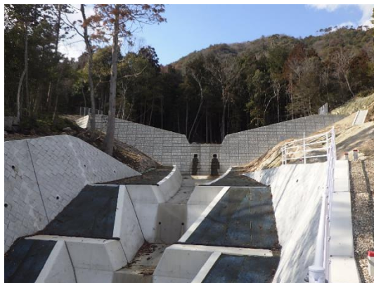
砂防事業の施工例
