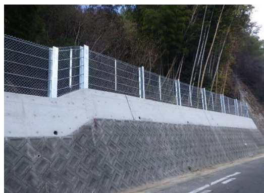
(主) 江田島大柿線 道路災害防除工事 (江田島市大柿町柿浦)
