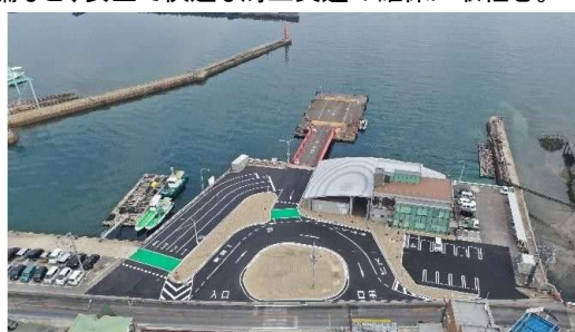
三高港ターミナル周辺整備
