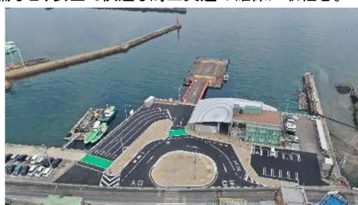
三高港ターミナル周辺整備
