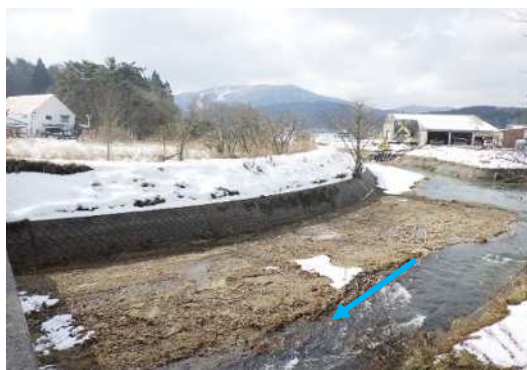
【水切りより上の土砂を除去した本県の事例】
