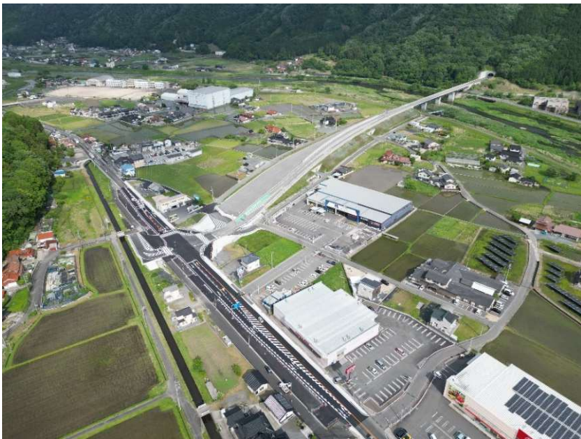
東広島高田道路（向原吉田道路） 供用開始
