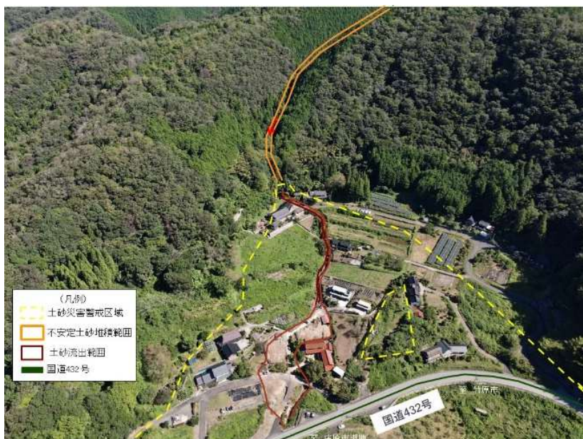
災害関連緊急砂防事業 本谷川
