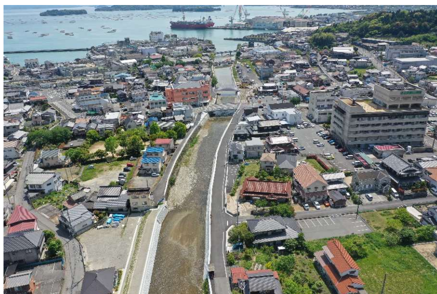
三津大川 災害復旧助成事業完了
