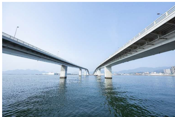
臨港道路廿日市草津線四車線化事業（Ⅱ期区間）
