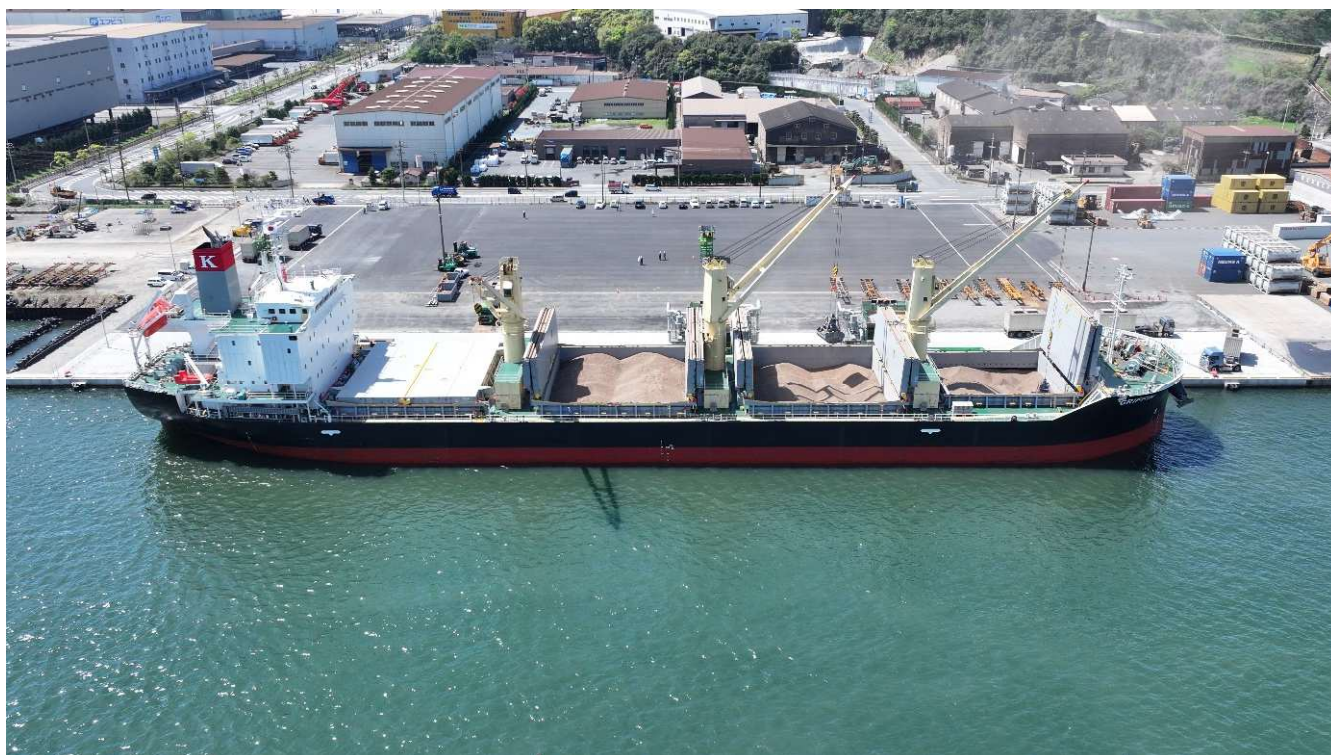
福山港ふ頭再編改良事業（箕島地区）の暫定供用開始
