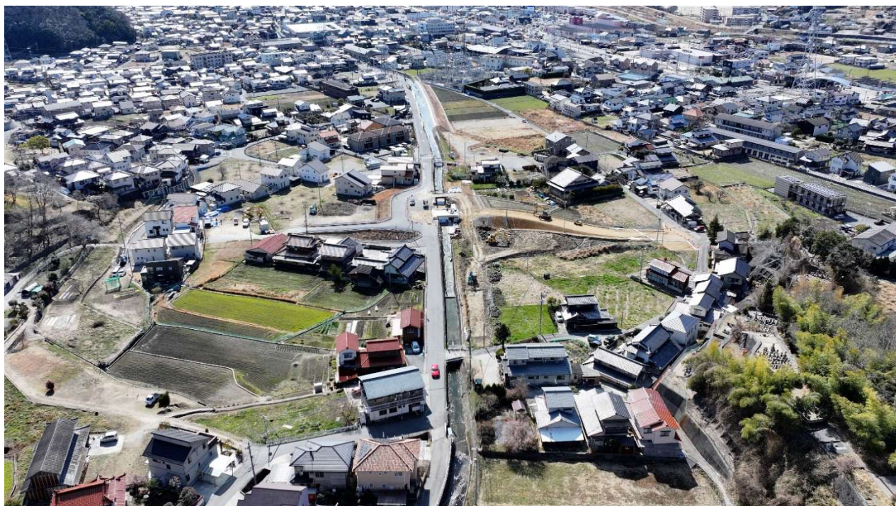
二級河川本川水系本川 浸水対策重点地域緊急事業（竹原市本町）
