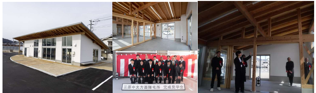
R 5 実施事例 建物完成見学会（三原市 三原中央方面隊屯所）
