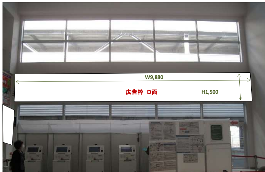
待合ホール吹抜部分壁面(D面)
