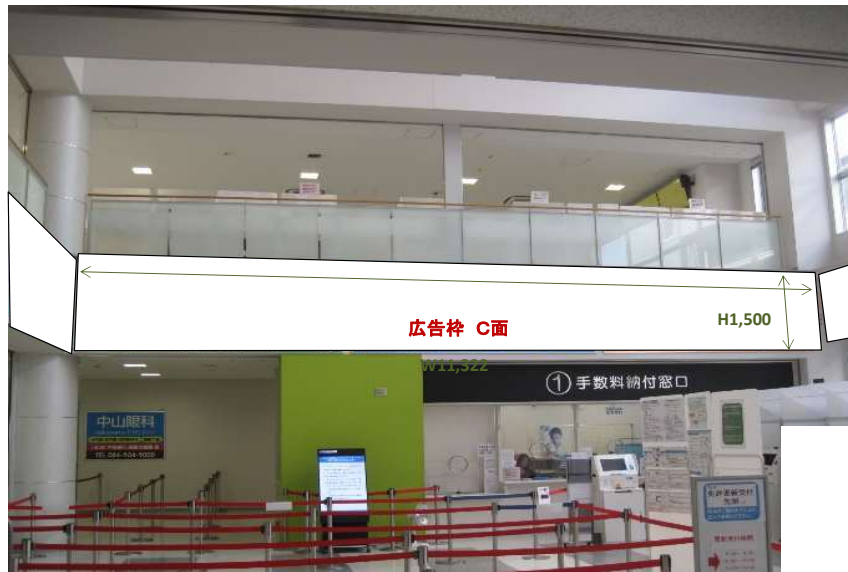
待合ホール吹抜部分壁面(C面)
