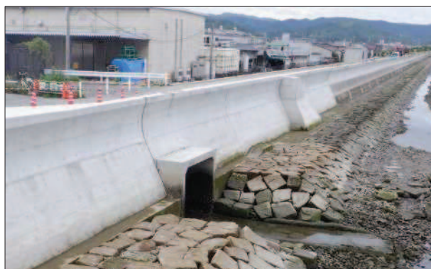
尾道糸崎港海岸堤防
