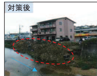
【河川堤防等の伐木】
