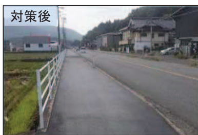
【路肩の堆積土除去及び歩道舗装】
