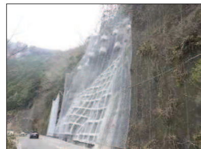
【法面对策の整備事例】
