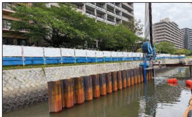
京橋川耐震対策工事実施状況
