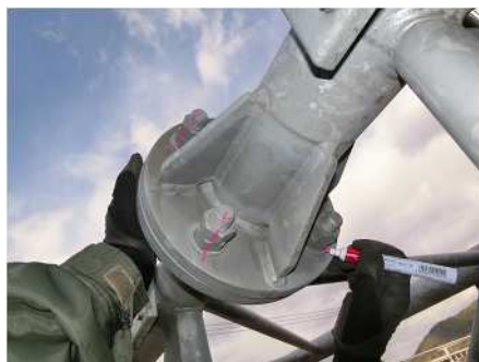
図 V-1 合いマーク施工状況
