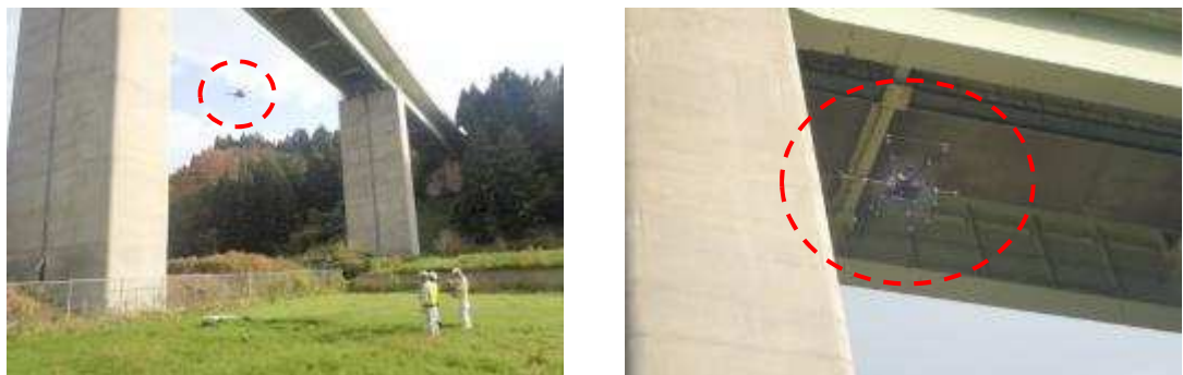
図Ⅱ－9 ドローンによる点検状況
