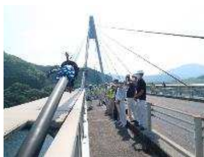
斜張橋のロボットによる点検
