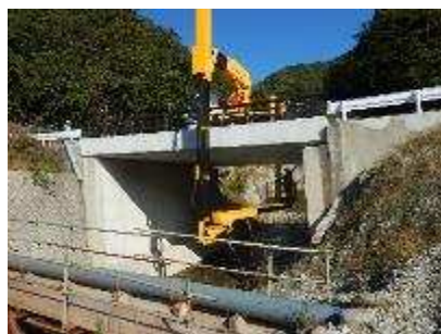
橋梁点検車による点検（委託）
