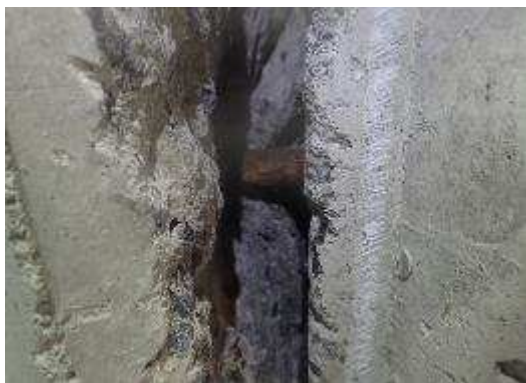
覆工アーチ部のはく落・鉄筋露出
