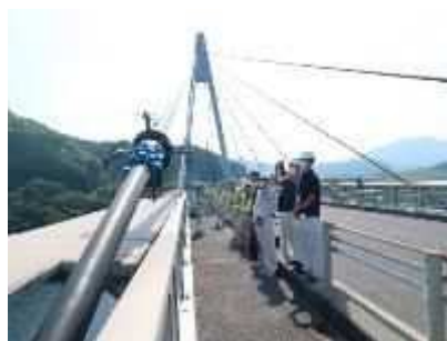
斜張橋のロボットによる点検
