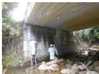
職員による点検（直営）
