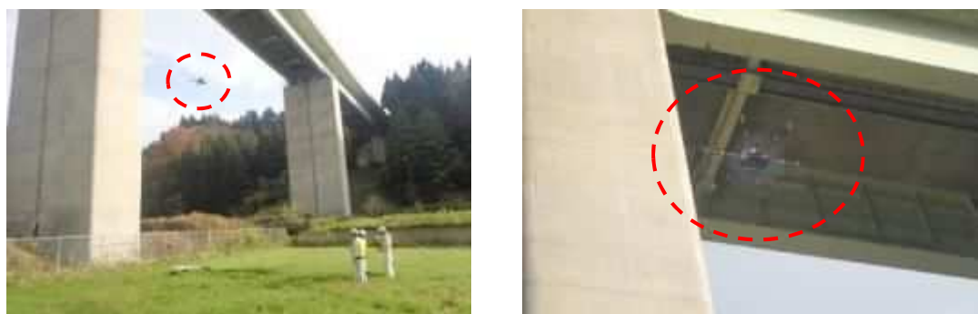
図Ⅱ－9 ドローンによる点検状況
