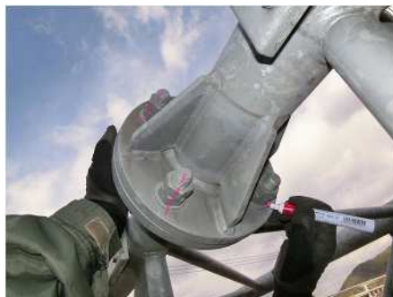
図 V-1 合いマーク施工状況
