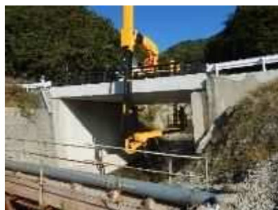
橋梁点検車による点検（委託）
