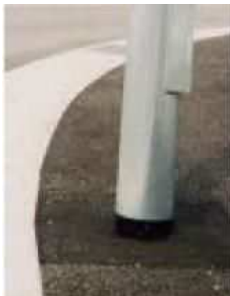
図 V-2 塗装処理状況
