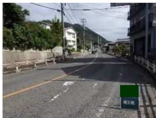
路面の損傷（ひび割れ）
