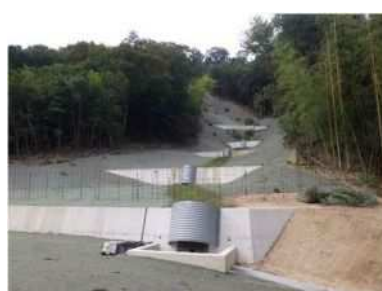
山腹工(土留工)
