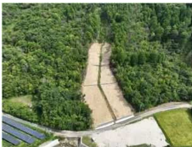
山腹工(東広島市)
