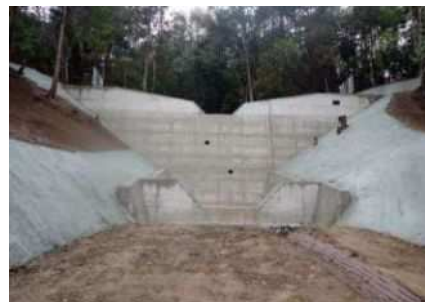
溪間工(安芸高田市)
