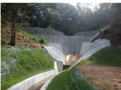
溪間工(谷止工)
