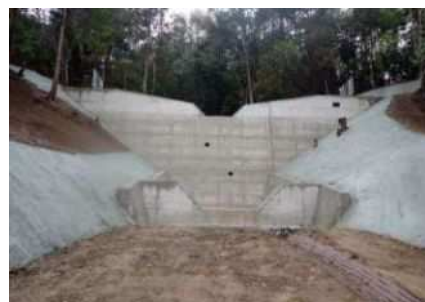
溪間工(安芸高田市)
