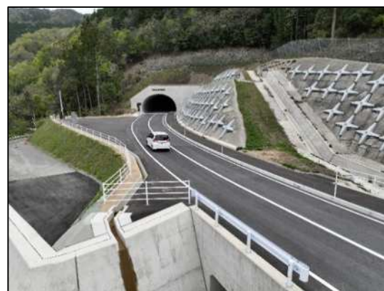
鳴瀬清流トンネル開通状況
