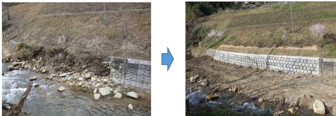
一級河川布野川 三次市布野町上 (左：被災状況, 右：完成)
