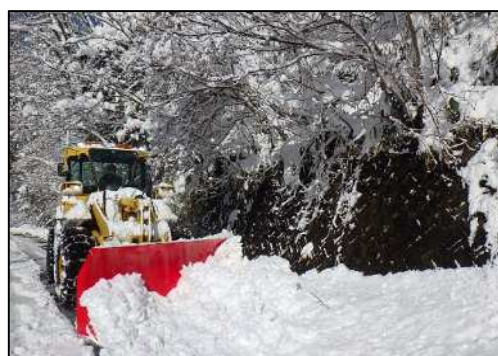
道路除雪状況
