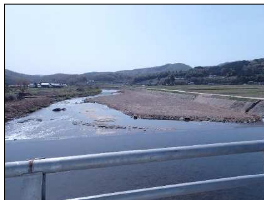
河川浚渫状況
