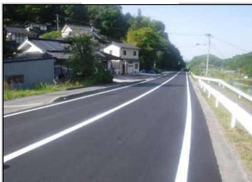
道路舗装補修状況
