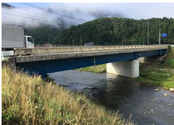
一般国道375号三若橋 三次市三若町
