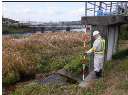
河川樋門点検状況
