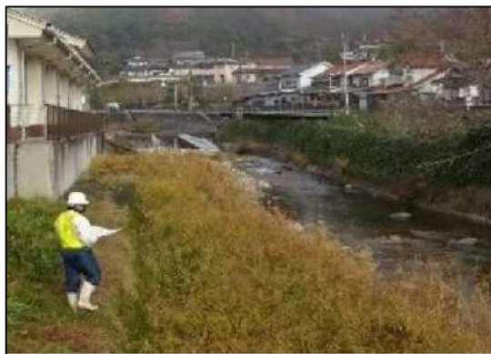
河川巡視状況
