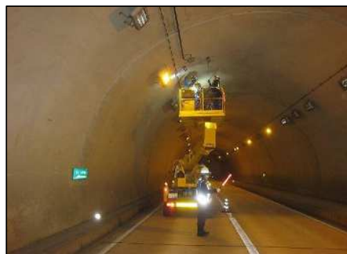
トンネル点検状況
