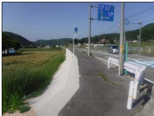
防草対策実施状況
