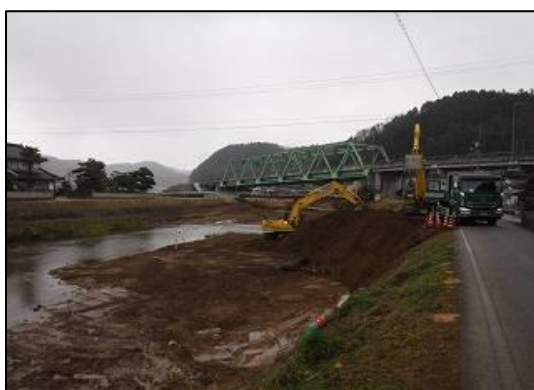
河川浚渫状況
