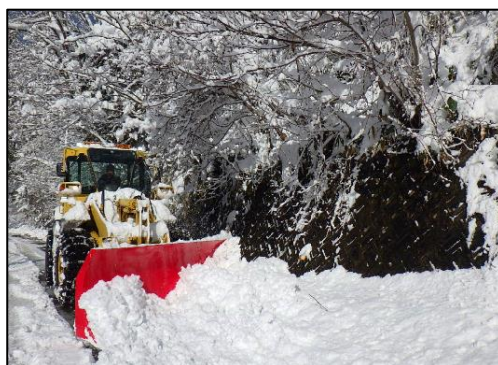
道路除雪状況
