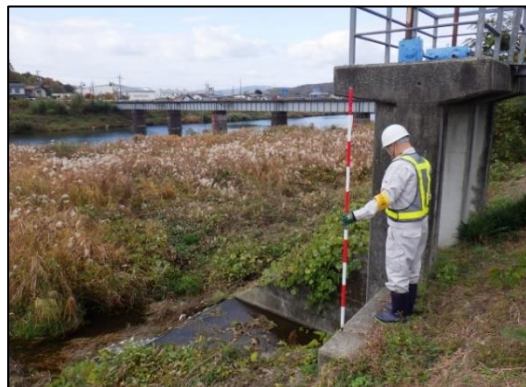
河川樋門点検状況
