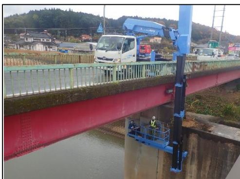
橋梁点検状況
