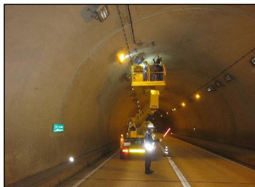
トンネル点検状況
