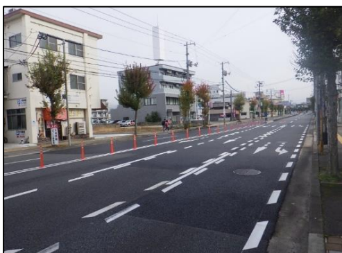
道路舗装補修状況
