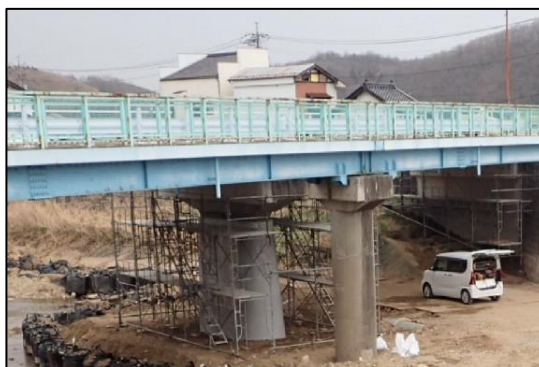
主要地方道広島三次線落合橋 耐震補強工事
