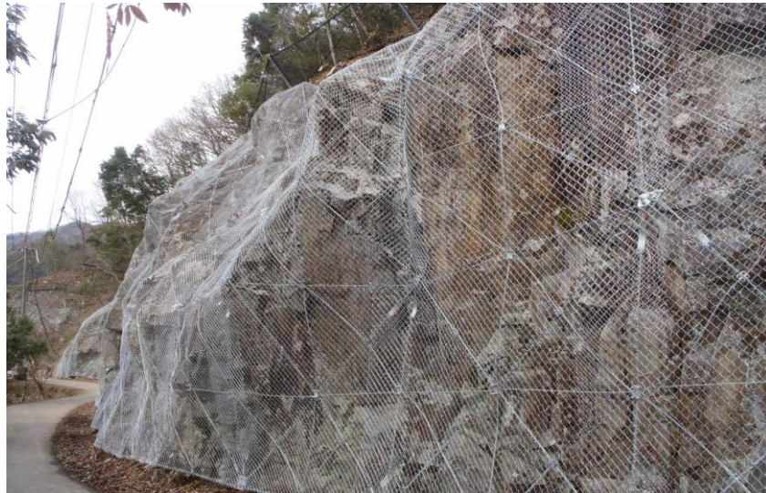
一般県道 下門田泉吉田線 君田町櫃田 法面防災工事
