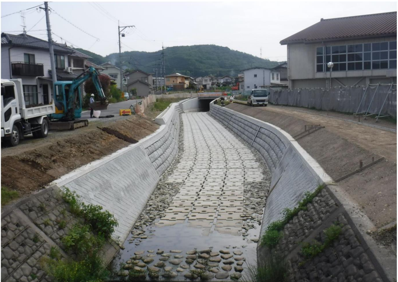
一級河川江の川水系 大谷川 三次市島敷町
