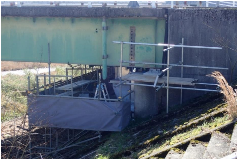
一般国道 375号 三次市粟屋町 日山橋耐震工事
