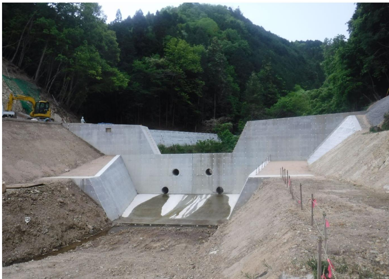
砂防指定地内河川 桜谷川 三次市吉舎町吉舎
