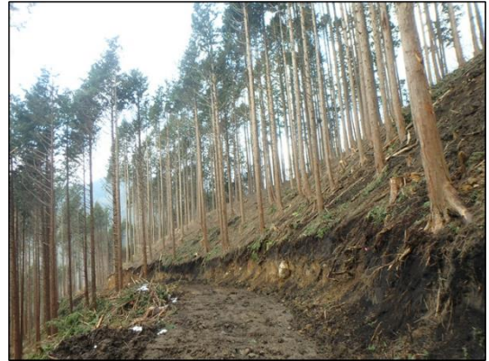
② 下井谷（庄原市）〔作業道開設〕
