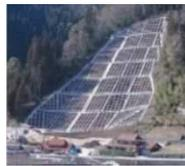
待受擁壁工, 法枠工
