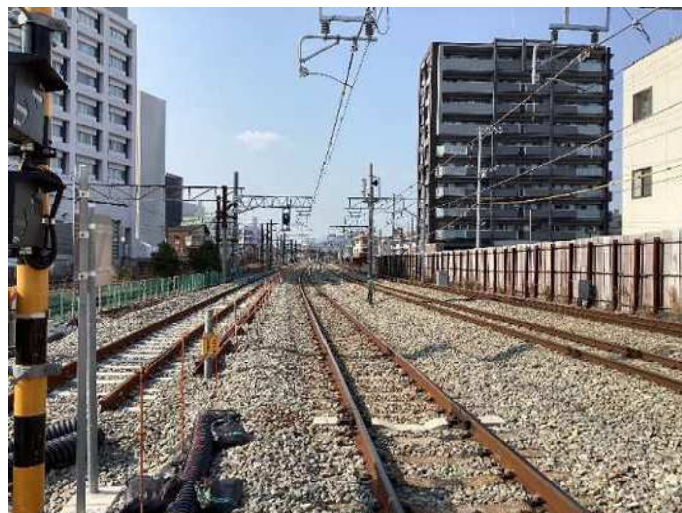
広島市東部地区連続立体交差事業における 仮路線（3線目）の運行開始
