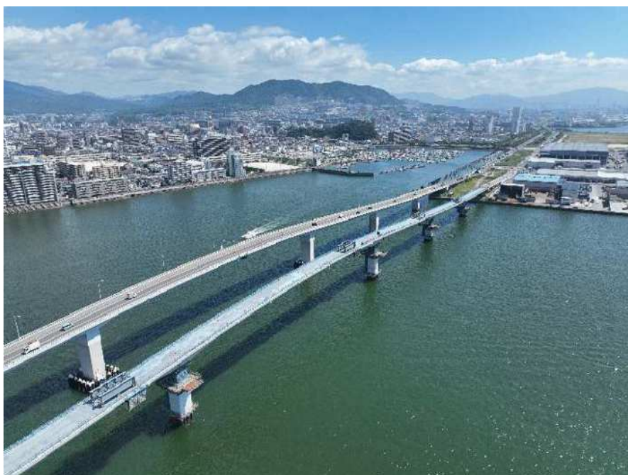
広島はつかいち大橋上部工の架設
