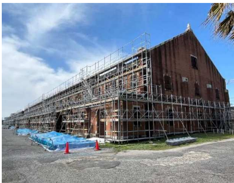
旧広島陸軍被服支廠安全対策工事状況
