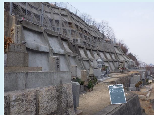
R6年度修繕事例（福山市）
