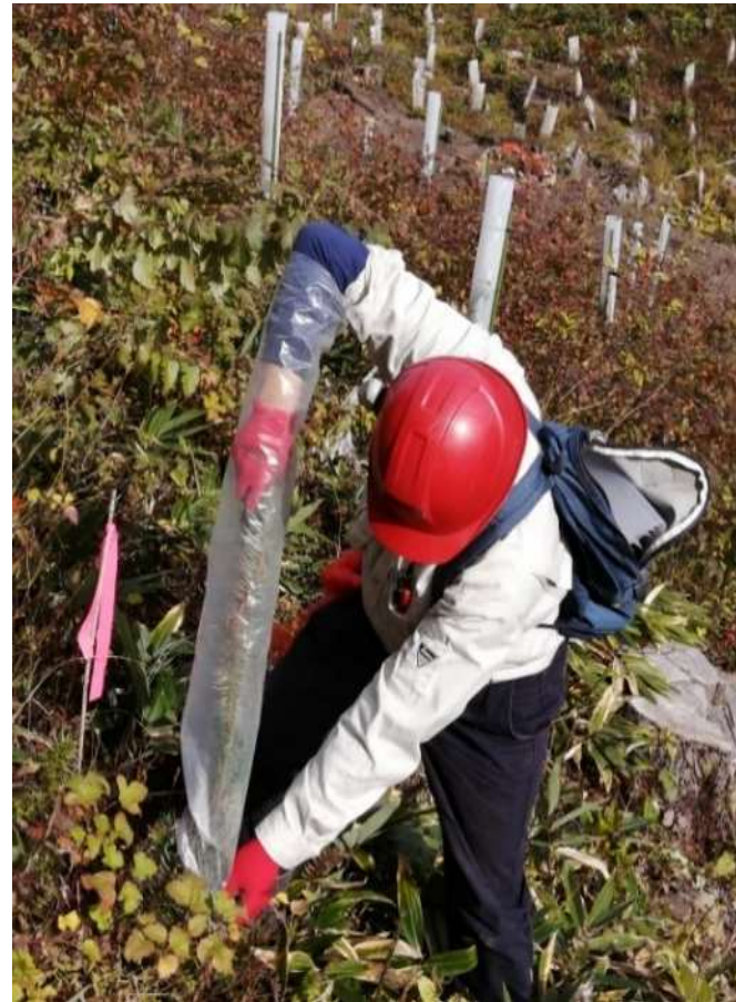
県試作Ⅱ型の施工状況
