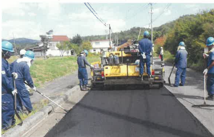
一般県道 本多田佐伯線 舗装補修（廿日市市浅原）
