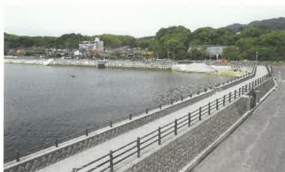
地御前漁港海岸（1 工区）
