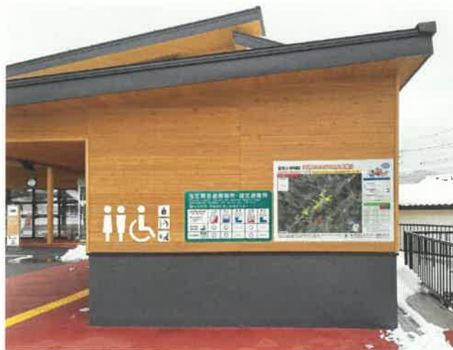
「土砂災害警戒区域を示した標識」 吉和ふれあい交流センター
