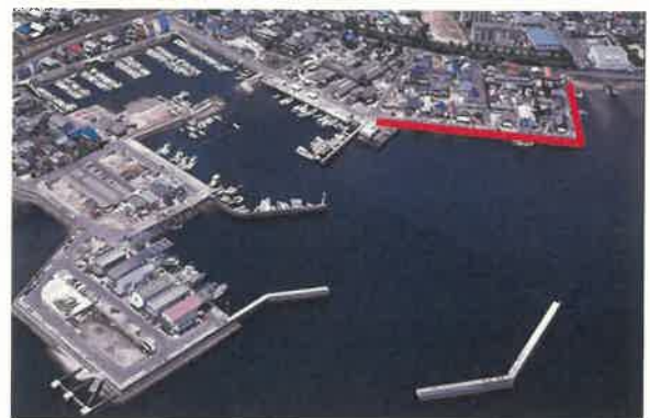
地御前漁港海岸（2工区）
