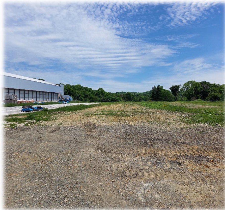
閉鎖鶏舎の解体・整地
