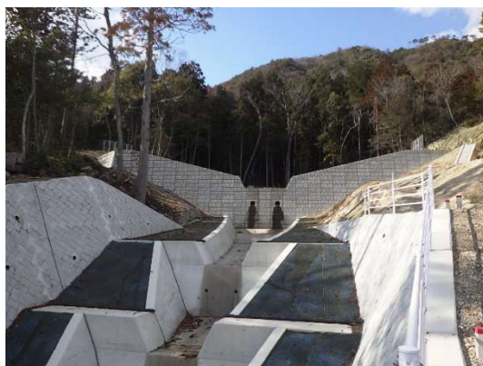
砂防事業の施工例
