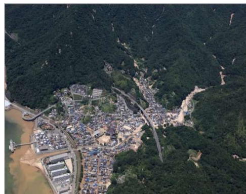
坂町小屋浦の被災状況
