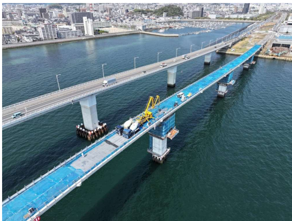
橋桁と橋脚の剛結工事（コンクリート打設）（2025.4.16）
