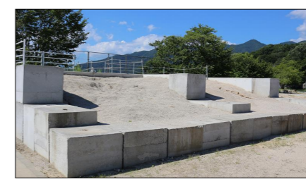
土砂災害対応訓練施設
