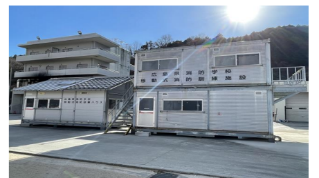
移動式消防訓練施設
