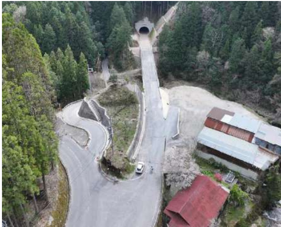
終点側からトンネルを望む
