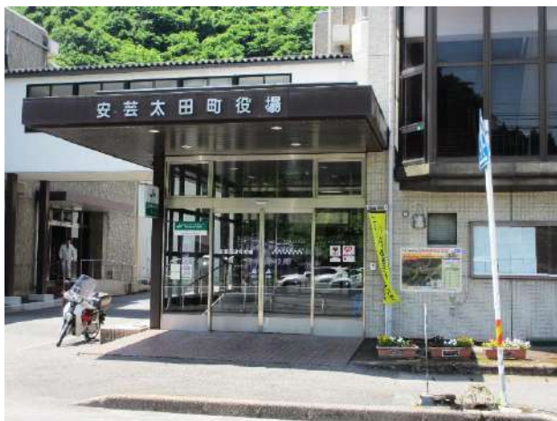
標識設置状況（安芸太田町役場）
