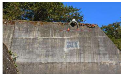
砂防堰堤点検状況
