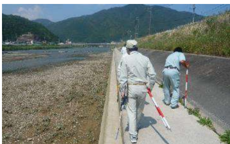
河川点検状況
