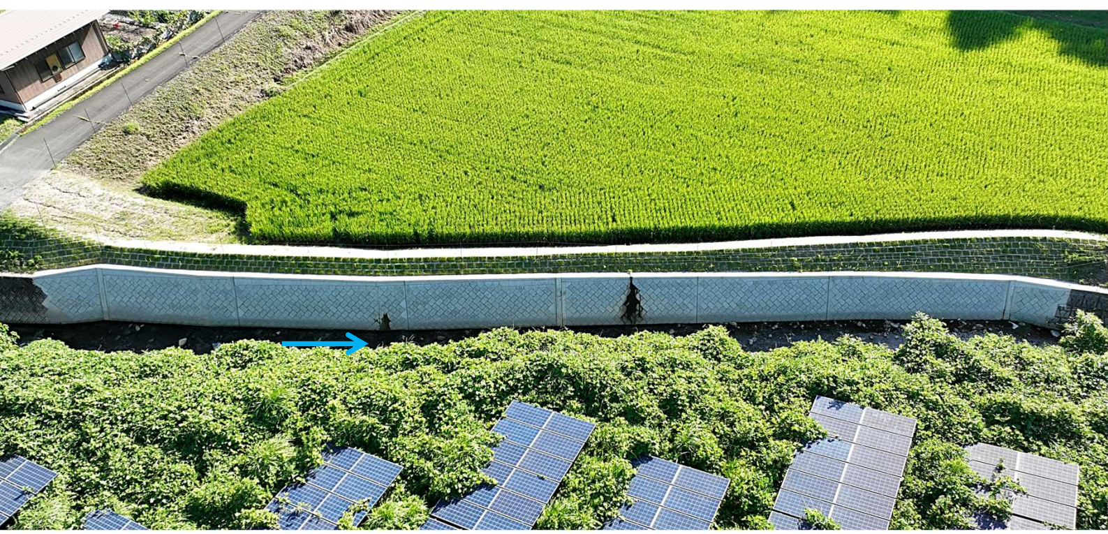
令和3年災害 第1773号 一級河川 冠川 木下鉄工所下 復旧後 令和6年2月完成
