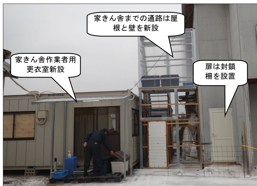
図3 新設した施設（C農場）
