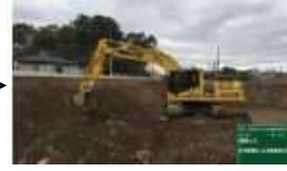
③ICT建設機械による施工
