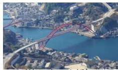
(第二音戸大橋)
