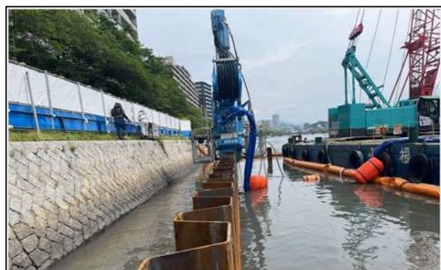
京橋川耐震対策工事実施状況
