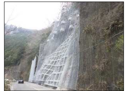
【法面对策の整備事例】
