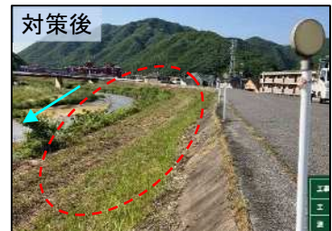
【河川堤防の伐木等】
