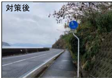
【歩道の伐木対策】
