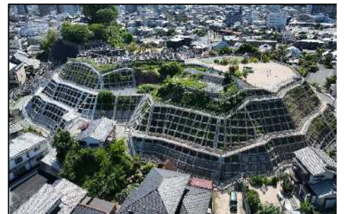
急傾斜地崩壊対策事業 （廿日市市 篠尾地区）
