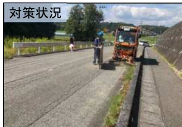
【専用機械による路肩の堆積土除去】
