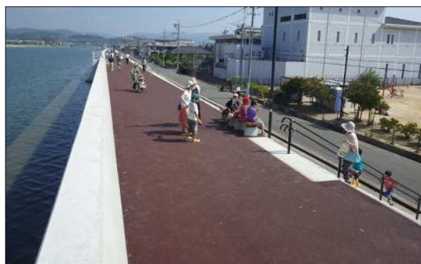
尾道糸崎港海岸堤防
