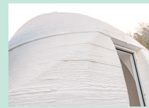
モルタル構造体を耐水性塗装で仕上げた外壁
