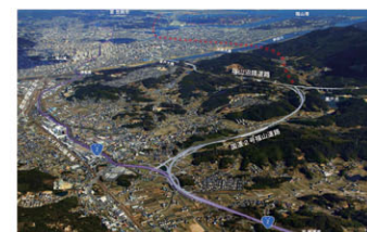
一般国道2号福山道路
