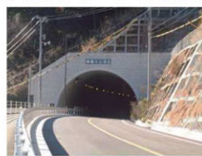
道路改良工事例（バイパス整備）
