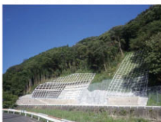
法面災害防除工事例（法枠工事）
