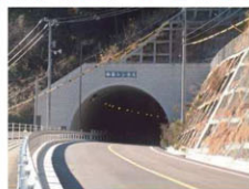
道路改良工事例 (バイパス整備)
