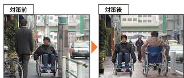
移動円滑化を妨げる電柱
