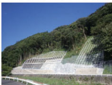
法面災害防除工事例 (法枠工等)
