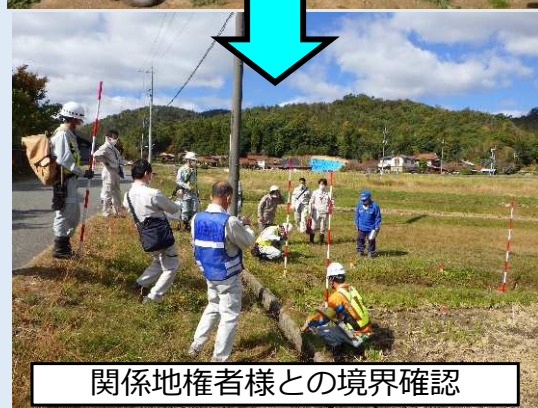
用地幅杭設置・境界復元作業
