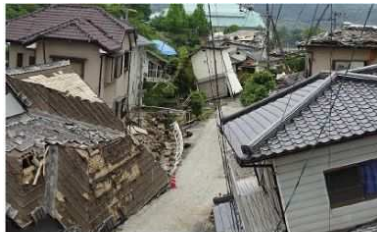
▲建物倒壊がれき
