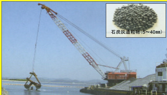
グラブ船による石炭灰造粒物の投入状況(参考)
