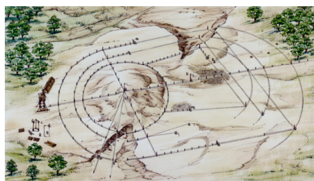
②設計図をもとに地面に線を描き、目印になるところに杭を打つ。
