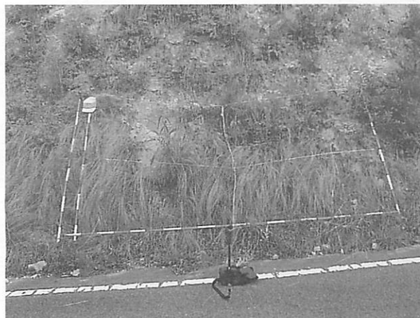
写真3 施工後10年4ヶ月後のネット種子工区の植生回復状況
