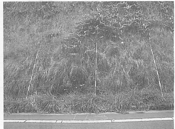
写真6 ネット客土工区の施工後7年4ヶ月後の植生回復状況
