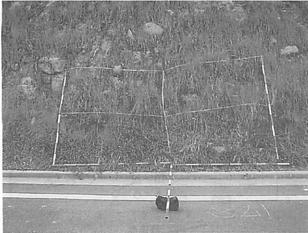
写真1 施工後2年4ヵ月後のネット種子工区の植生回復状況
