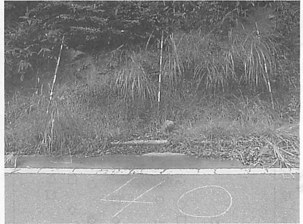
写真4 種子工区の施工後7年4ヵ月後の植生回復状況
