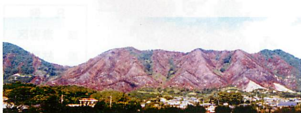
写真-1 現場全域のパノラマ写真
