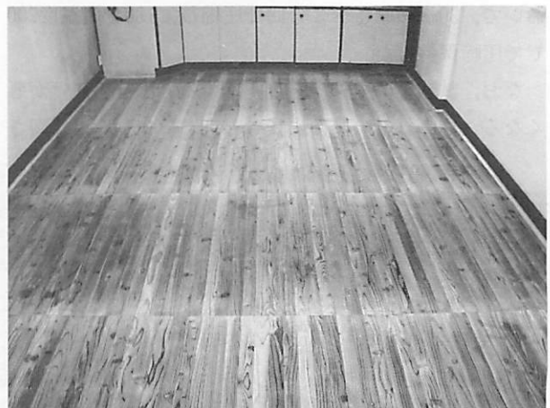
写真6 床板パネル施工状況
