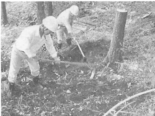
写真1 手作業による根系の露出化の様子
