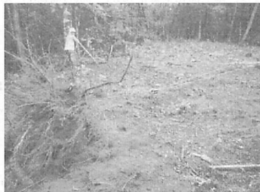
写真2 重機またはチルホールによる根系の引き抜きの様子
