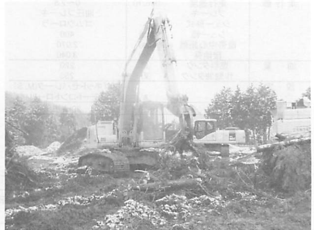
写真-7 専用土場Aの小割作業
