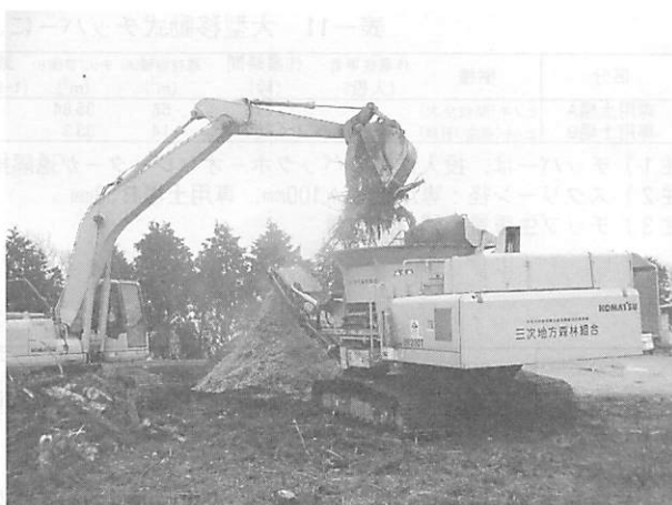
写真-9 専用土場Aの投入作業
