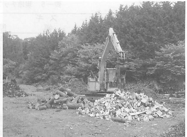
写真-8 専用土場Bの小割作業
