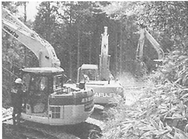
写真-1 機械の配置状況 (吉田試験地)
