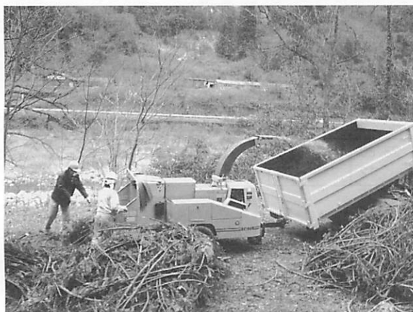
写真-3 現地チップ化試験状況
