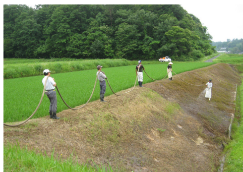
【 センチピートグラス吹き付け作業 】
