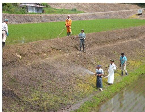
【吹付作業の様子】
